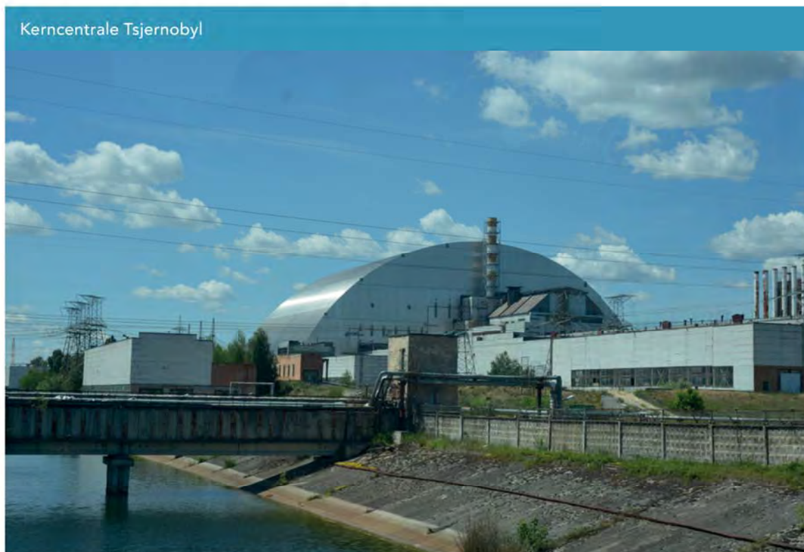
Figuur 3: Kerncentrale Tsjernobyl in 2017, waarbij de boogvormige overkapping is te zien die is geplaatst over de verwoeste reactor van de kerncentrale. (Bron: Onderzoeksraad voor Veiligheid)
