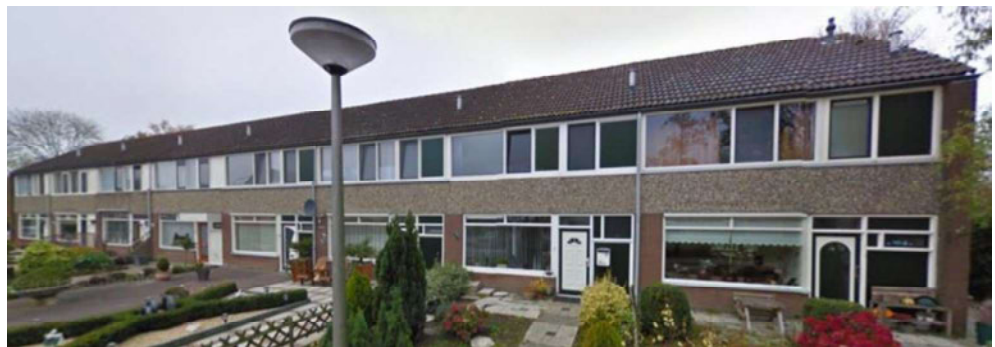
Figuur 1: Ter illustratie: voorbeelden van gebouwen in BETON1a.
