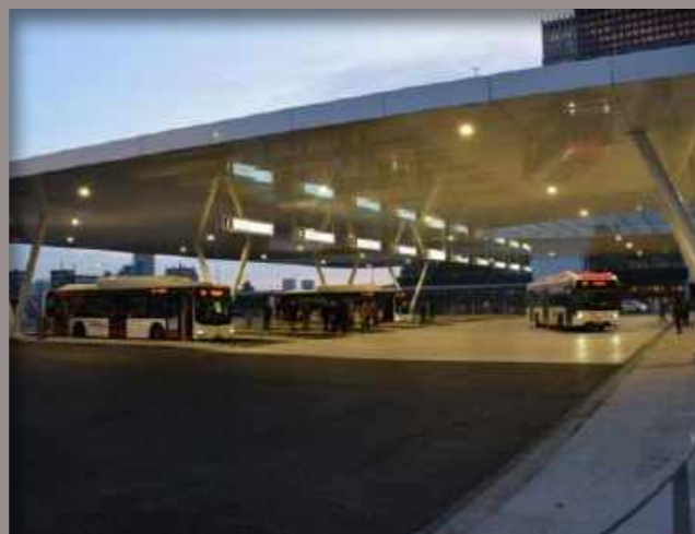
1. Opgetild busstation met overkapping
