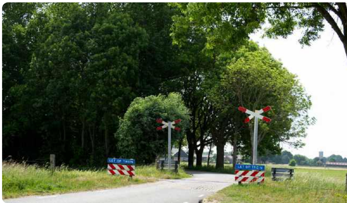
Figuur 10: Overweg Zanddijk, vanuit noordelijke richting gezien (mei 2025) (bron: Onderzoeksraad voor Veiligheid).
