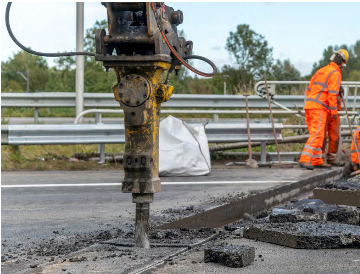
Verwijdering van asfalt ten behoeve van werkzaamheden en reparaties.
