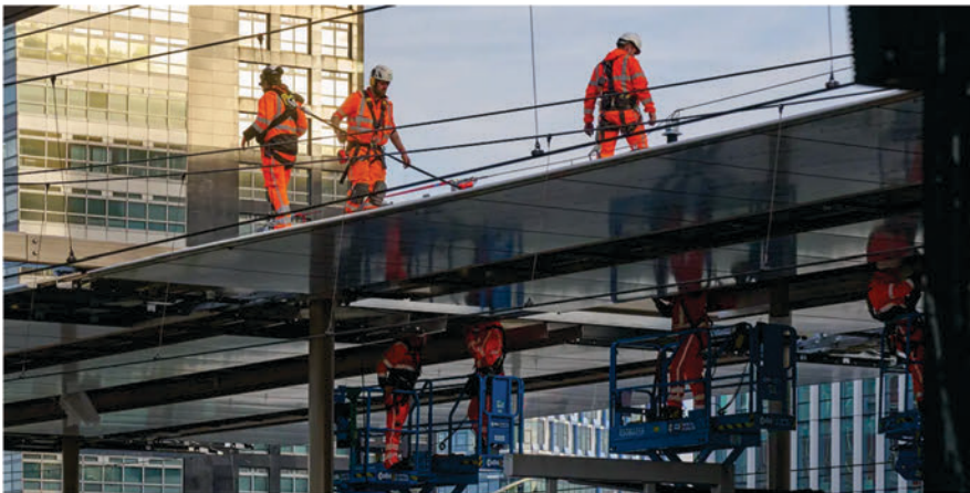
Op station Amsterdam Zuid werd er een nieuwe perronkap geplaatst.
