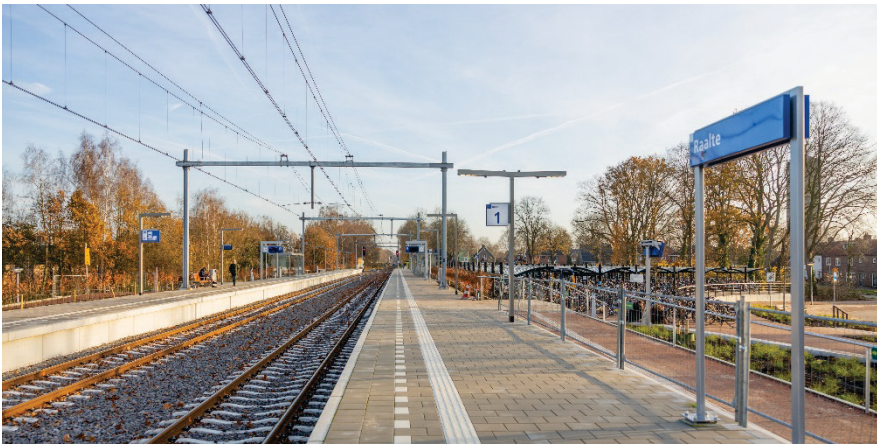
Station Raalte is opnieuw geopend, met onderpassage en nieuwe entree.
