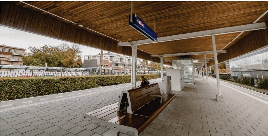
Station Heiloo met nieuwe duurzame perronkap.
